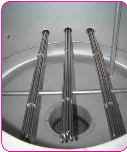
inschroefelementen onder in een RVS tank
